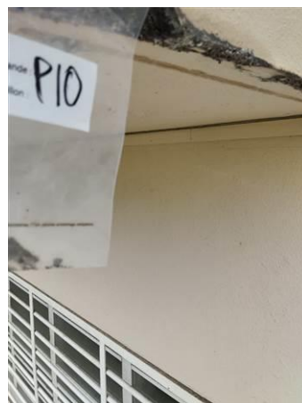
Matériaux : Z02 - Façades - Sous face balcon - Enduit + peinture Prélèvement : P010 Description : enduit + peinture Localisation : BAT 4 - Façade avant gauche - Sous face balcon Résultat : Absence d'amiante
