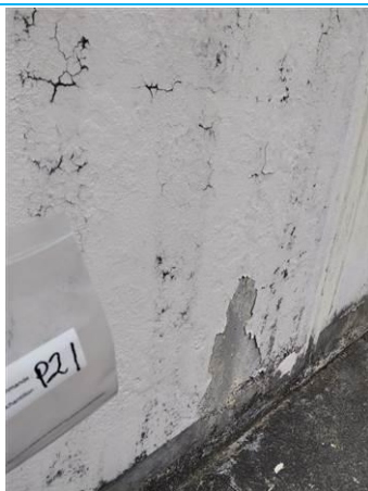
Matériaux : Z08 - Façades - Mur - Enduit + peinture Prélèvement : P021 Description : enduit + peinture Localisation : BAT 4 - Façade avant droite - Mur bas Résultat : Absence d'amiante
