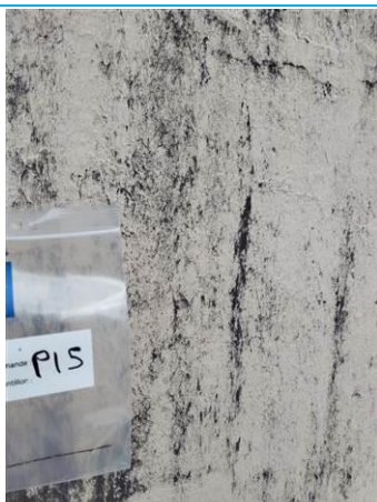
Matériaux : Z01 - Pignons - Mur haut - enduit + peinture Prélèvement : P015 Description : enduit + peinture Localisation : BAT 4 - 1er pignon - Mur milieu Résultat : Absence d'amiante
