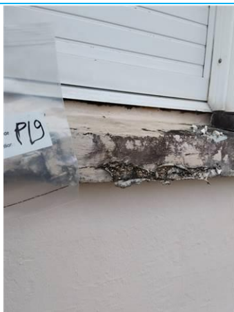
Matériaux : Z07 - Façades - Appuie fenêtre - Enduit + peinture Prélèvement : P019 Description : enduit + peinture Localisation : BAT 4 - Façade avant droite - Appuie fenêtre Résultat : Absence d'amiante
