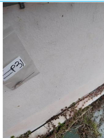
Matériaux : Z08 - Façades - Mur - Enduit + peinture Prélèvement : P031 Description : enduit + peinture Localisation : BAT 4 - Façade arrière gauche - Mur bas Résultat : Absence d'amiante
