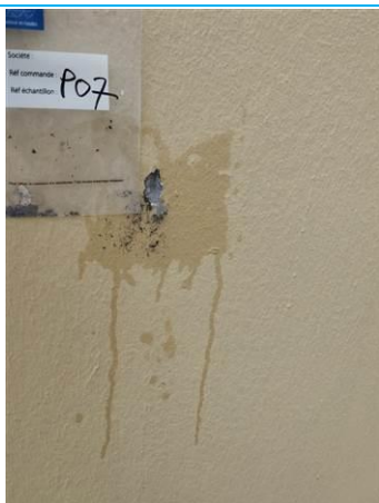
Matériaux : Z13 - Façades - Avancé - Enduit + peinture Prélèvement : P007 Description : enduit + peinture Localisation : BAT 4 - Façade avant gauche - Avancé balcon Résultat : Absence d'amiante
