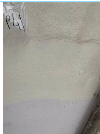
Matériaux : Z08 - Façades - Mur - Enduit + peinture Prélèvement : P041 Description : enduit + peinture Localisation : BAT 4 - Façade arrière droite - Mur bas Résultat : Absence d'amiante
