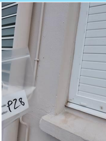
Matériaux : Z04 - Pignons, Façades - Embrasure fenêtre - Enduit + peinture Prélèvement : P028 Description : enduit + peinture Localisation : BAT 4 - Façade arrière gauche - Embrasure fenêtre Résultat : Absence d'amiante
