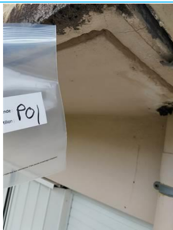
Matériaux : Z06 - Facades - Sous face casquette - Enduit + peinture Prélèvement : P001 Description : enduit + peinture Localisation : BAT 4 - Façade avant gauche Résultat : Absence d'amiante
