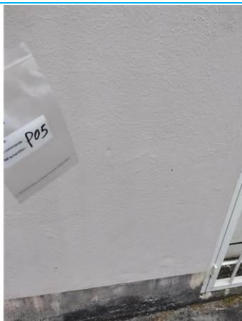
Matériaux : Z08 - Façades - Mur - Enduit + peinture Prélèvement : P005 Description : enduit + peinture Localisation : BAT 4 - Façade avant gauche - Mur bas Résultat : Absence d'amiante
