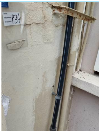
Matériaux : Z13 - Façades - Avancé - Enduit + peinture Prélèvement : P034 Description : enduit + peinture Localisation : BAT 4 - Façade arrière gauche - Avancé Cage escalier Résultat : Absence d'amiante
