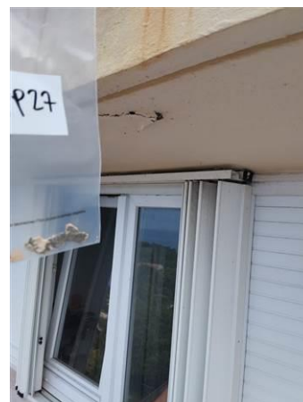
Matériaux : Z06 - Façades - Sous face casquette - Enduit + peinture Prélèvement : P027 Description : enduit + peinture Localisation : BAT 4 - Façade arrière gauche - Sous face casquette Résultat : Absence d'amiante
