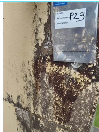
Matériaux : Z13 - Façades - Avancé - Enduit + peinture Prélèvement : P023 Description : enduit + peinture Localisation : BAT 4 - Façade avant droite - Avancé balcon Résultat : Absence d'amiante
